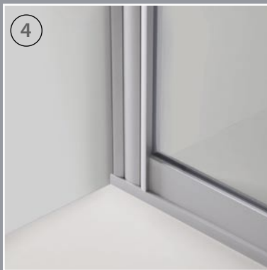
4 Кріплення панелі до нерівної стіни Крепление панели к неровной стене
