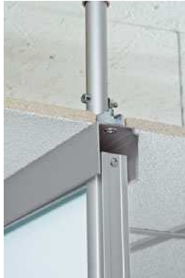
Montaż toru górnego za pomocą łącznika toru.
